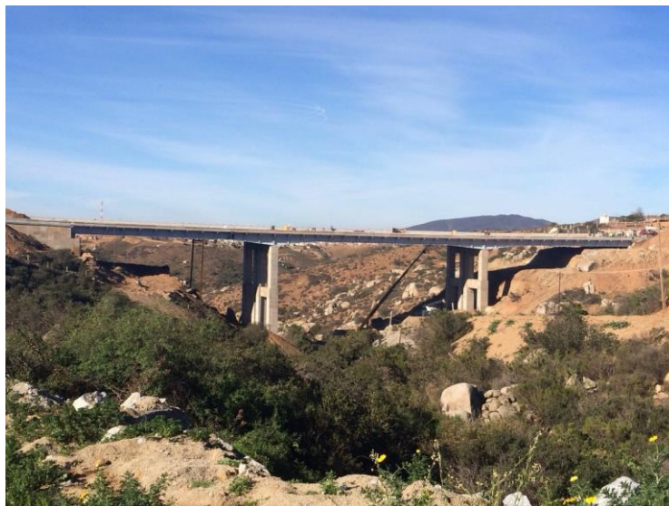
Construcción de Puente "Colinas del Rey" en el Libramiento Ensenada
