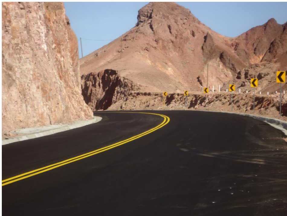
Modernización de la carretera Mexicali-San Felipe
