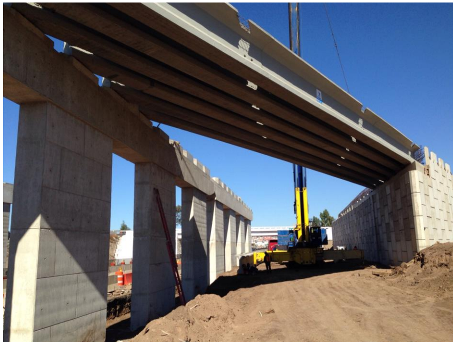
Puente Colinas del Sur, Mexicali, Baja California
