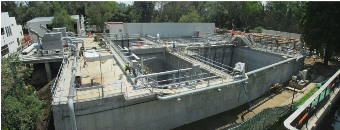
Construcción de la Planta de Tratamiento de Aguas Residuales en Chapultepec.
