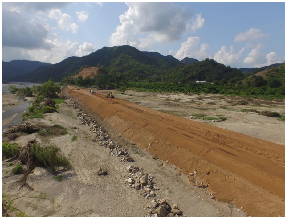
Construcción y reconstrucción de la infraestructura hidroagrícola.
