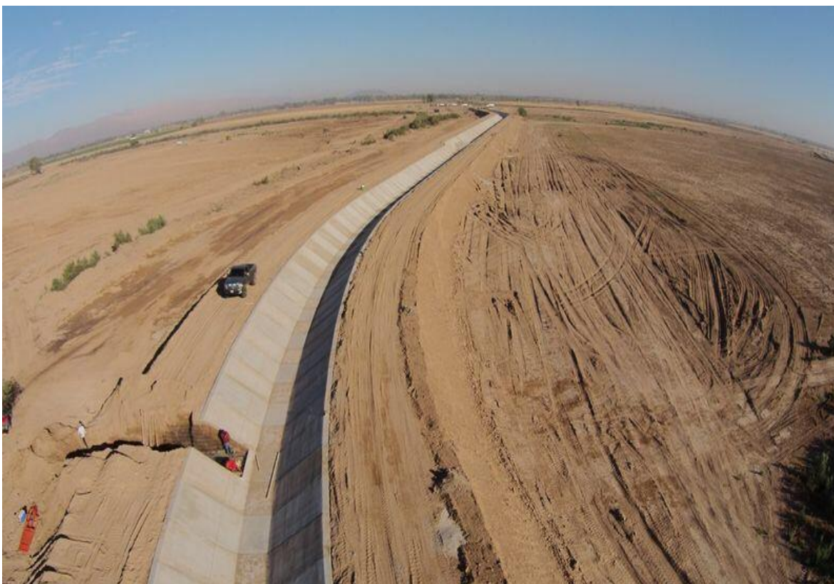
Construcción y reconstrucción de la infraestructura hidroagrícola.
